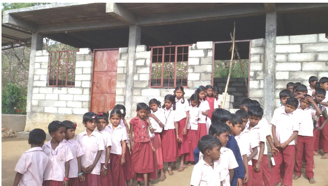
Rohbau des Schlafsaals
